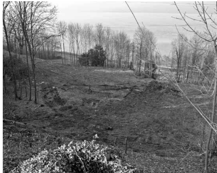
4) Der Bereich der Eremitage anfangs März 2007, kurz nach den Rodungsarbeiten im Vorfeld der Grabungen.
